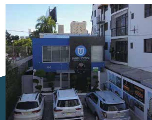
CONSTRUCCIÓN OFICINA MELCON SANTO DOMINGO
