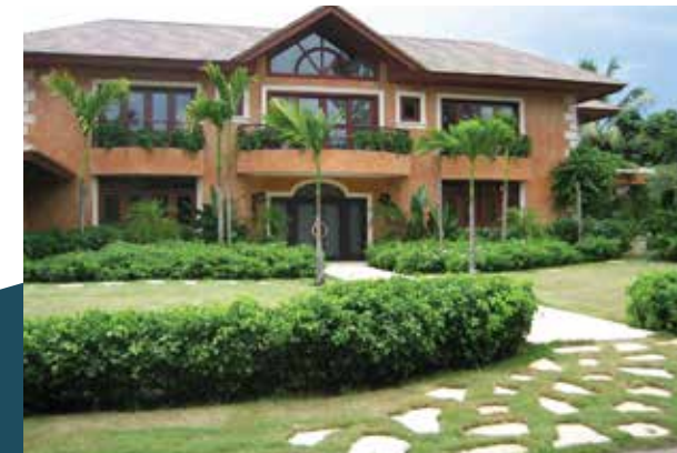
CONSTRUCCIÓN VILLA PUNTA ÁGUILA #41 CASA DE CAMPO, LA ROMANA
