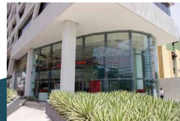
CONSTRUCCIÓN OFICINAS JMMB DOMINICANA, CORPORATIVO 2010 SANTO DOMINGO
