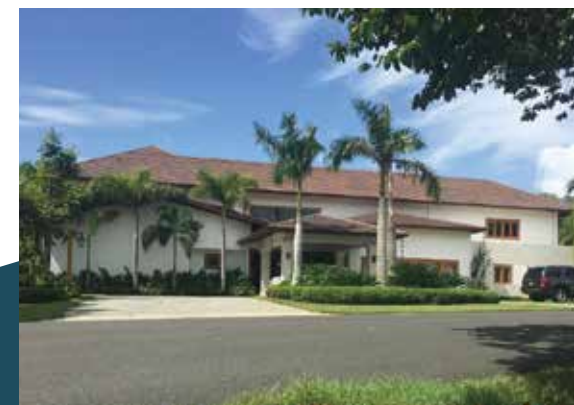
CONSTRUCCIÓN VILLA BARRANCA OESTE #38 CASA DE CAMPO
