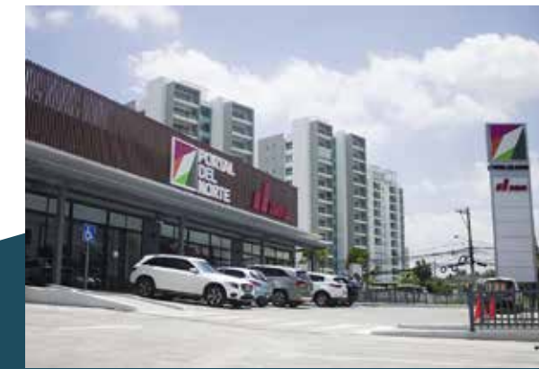
CONSTRUCCIÓN PLAZA PORTAL DEL NORTE SANTIAGO
