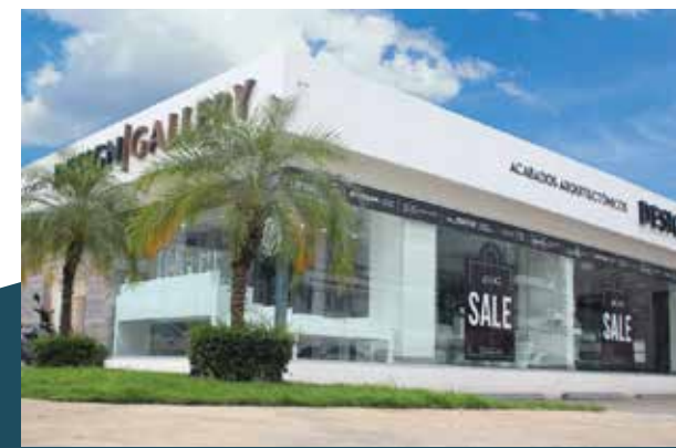
CONSTRUCCIÓN LOCAL COMERCIAL DESIGN GALLERY SANTO DOMINGO
